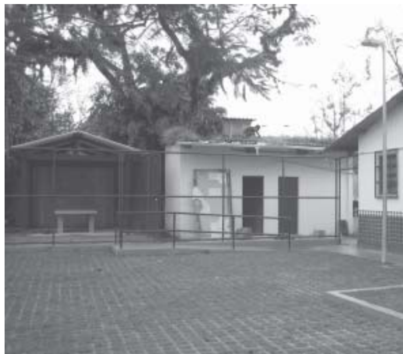
Figura 1. Unidade experimental-demonstrativa do telhado verde e aproveitamento de águas pluviais (ao fundo) do projeto HIDROCIDADES desenvolvido pela UERJ com apoio do CNPq e da FAPERJ e, pavimento permeável de blocos vazados na Escola Municipal Teófilo Moreira da Costa, Jacarepaguá ( Pimentel da Silva et al., 2008b ).
